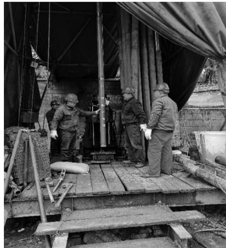
图5 堵漏工具与钻杆相连后准备下井
